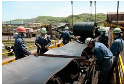
コンベアベルトエンドレス施工
