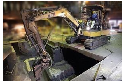
高炉溶銑樋の解体
