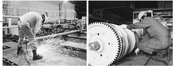
鋼材手入加工、天井クレーンの車輪整備
