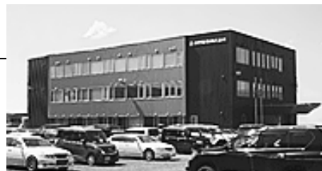
令和2年12月完成の本新社屋
