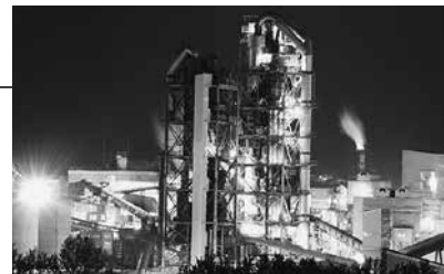
工場夜景 （セメントキルンと予熱塔）
